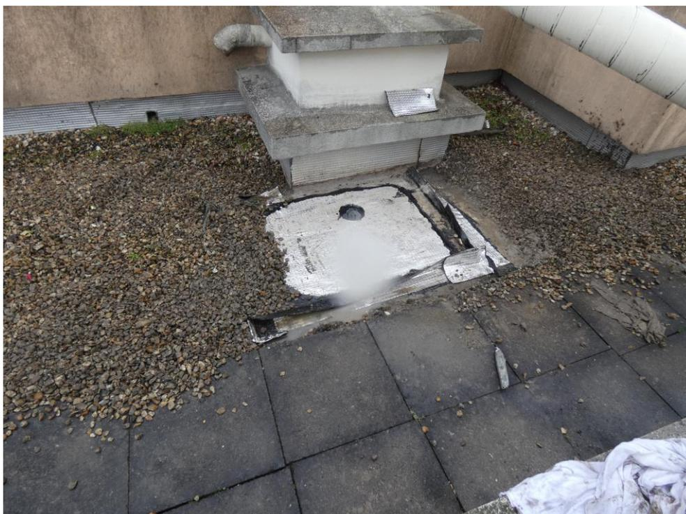
Finition de l'étanchéité sur le sondage.
