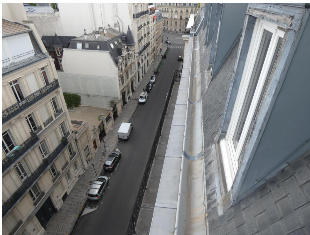
Zone d'intervention par nos soins, réparations de plusieurs jonctions de chéneau.
