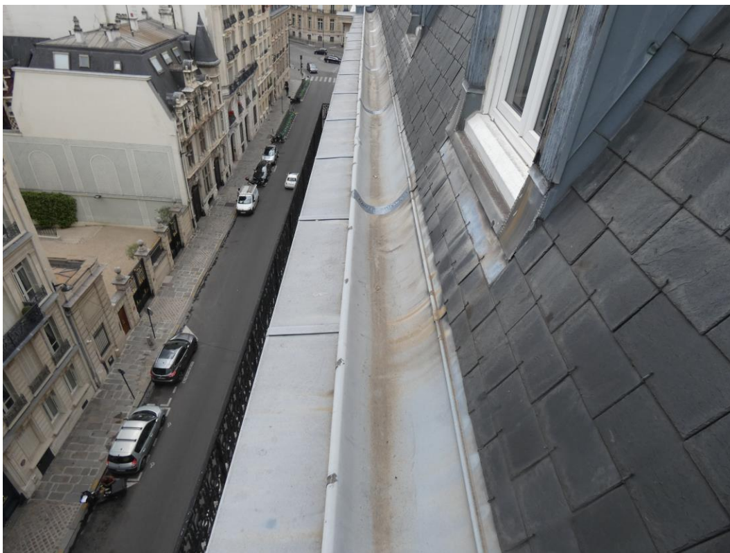
Réparation des soudures suite à notre passage.
