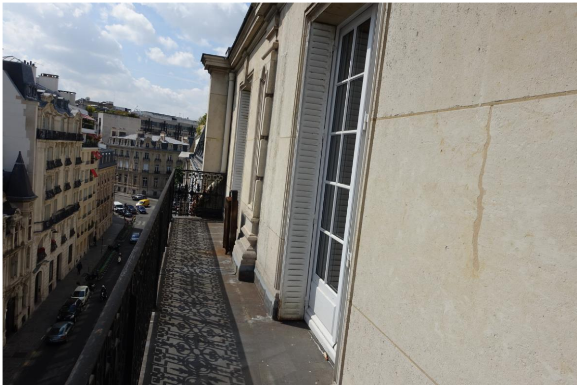
Localisation : derrière le garde-corps.
